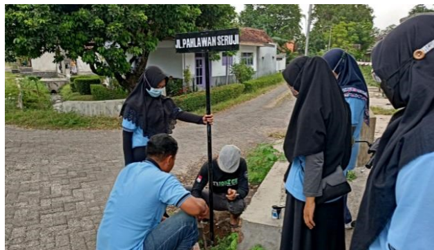
Gambar 6. Pemasangan Papan Nama Jalan
