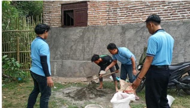
Gambar 5. Pembuatan adonan semen dengan pasir
